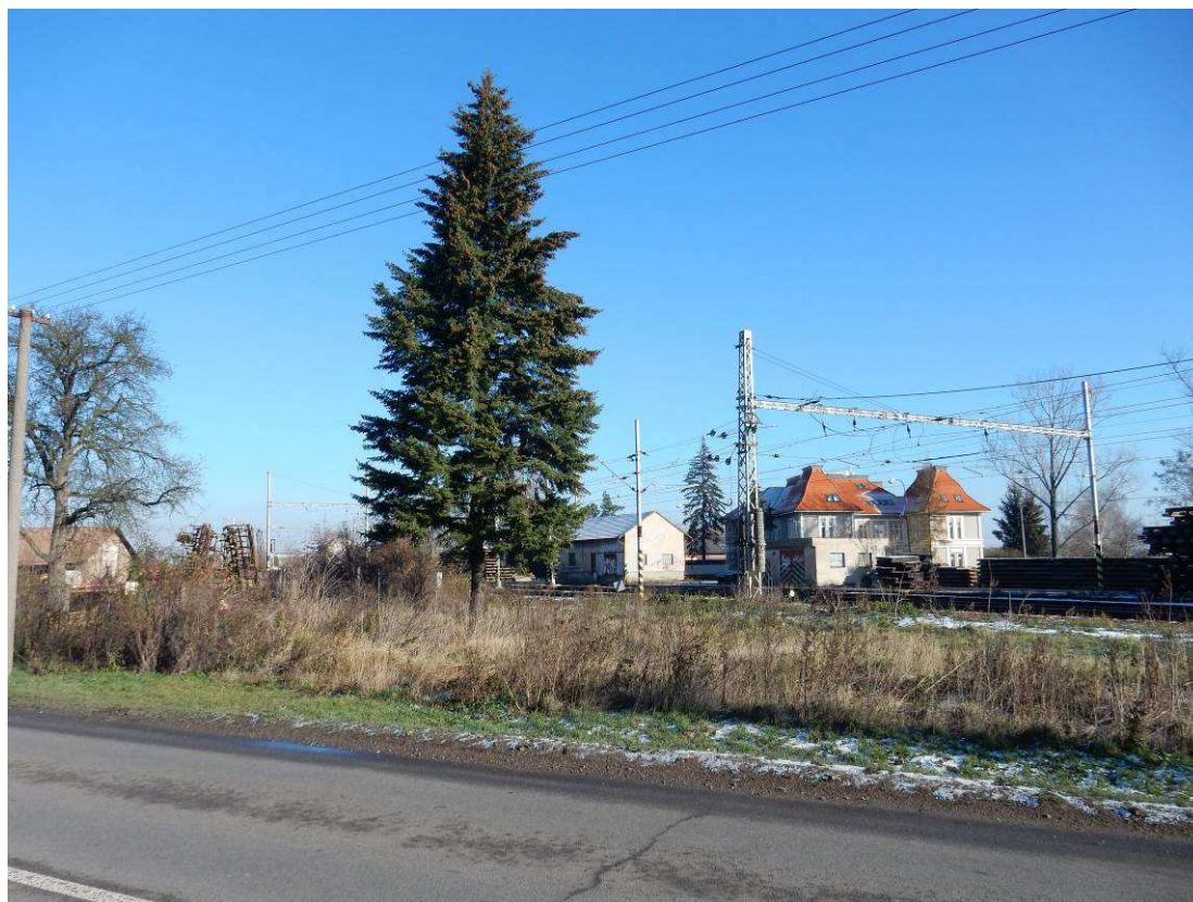
Obr. Mohutnější douglaska u žst. Opatovice nad Labem (km 16,5)
