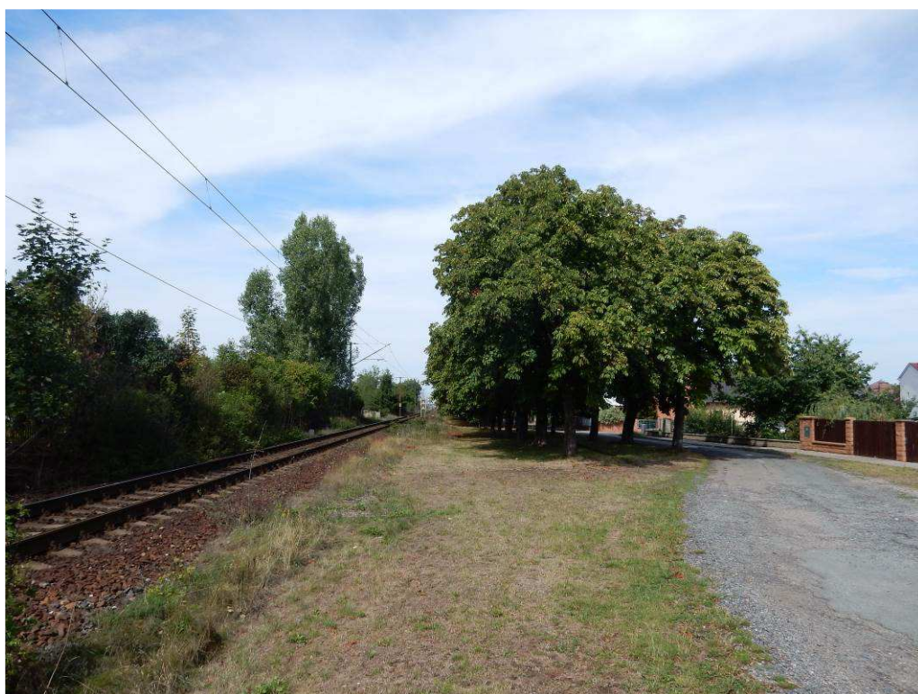
Obr. km 21,1 - Opatovická ulice, alej jírovců madřalů
