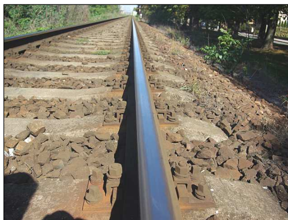
Detail železničního svršku
