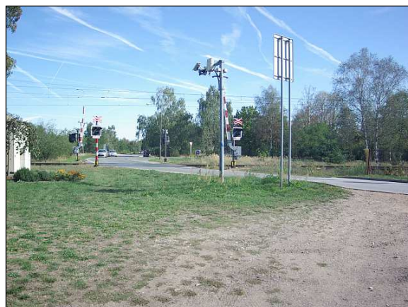
Bod 2 – pohled z místa měření na trať
