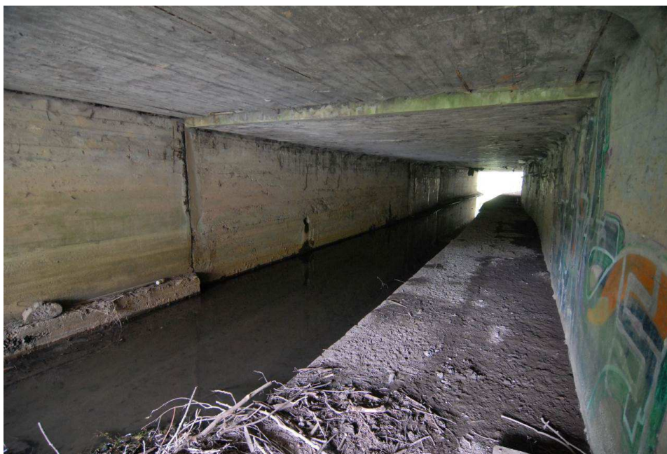
Obr.č.32 SO 20-34-01 Železniční most ev. km 17,288
