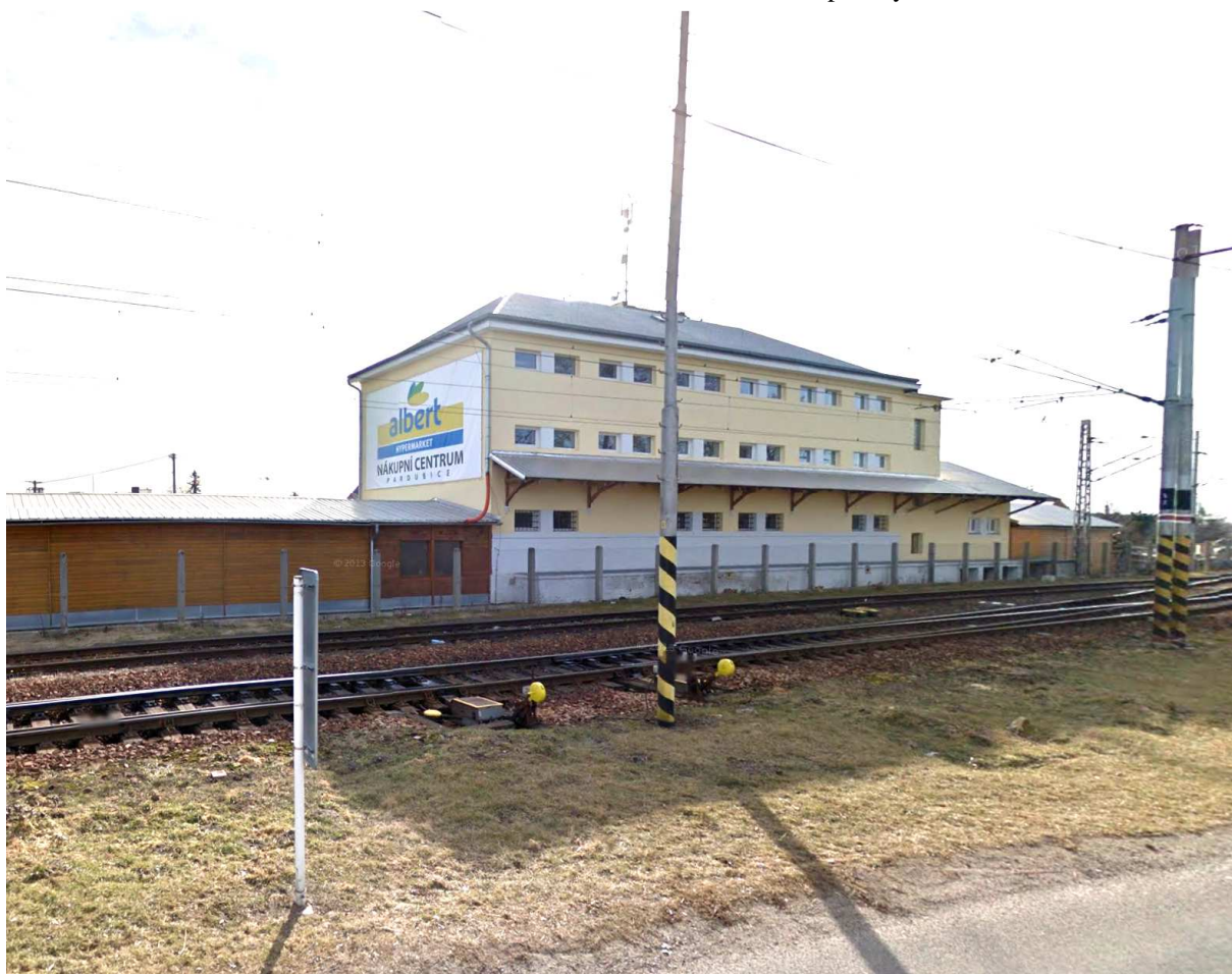
Obr.č.21 Objekt skladů č.p. 110, který je v KN veden jako objekt pro bydlení.
